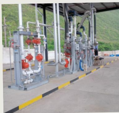
Cette nouvelle installation est équipée du dernier système automatisé de terminal, incluant l'application Fuel-Facs et Danload 800. Il s'agit du système de chargement de carburants le plus perfectionné dans la région des Caraïbes. Ce système réduit la dépendance de l'intervention manuelle, diminue la
